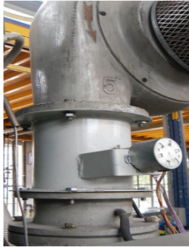
图 1 风门安装示意
